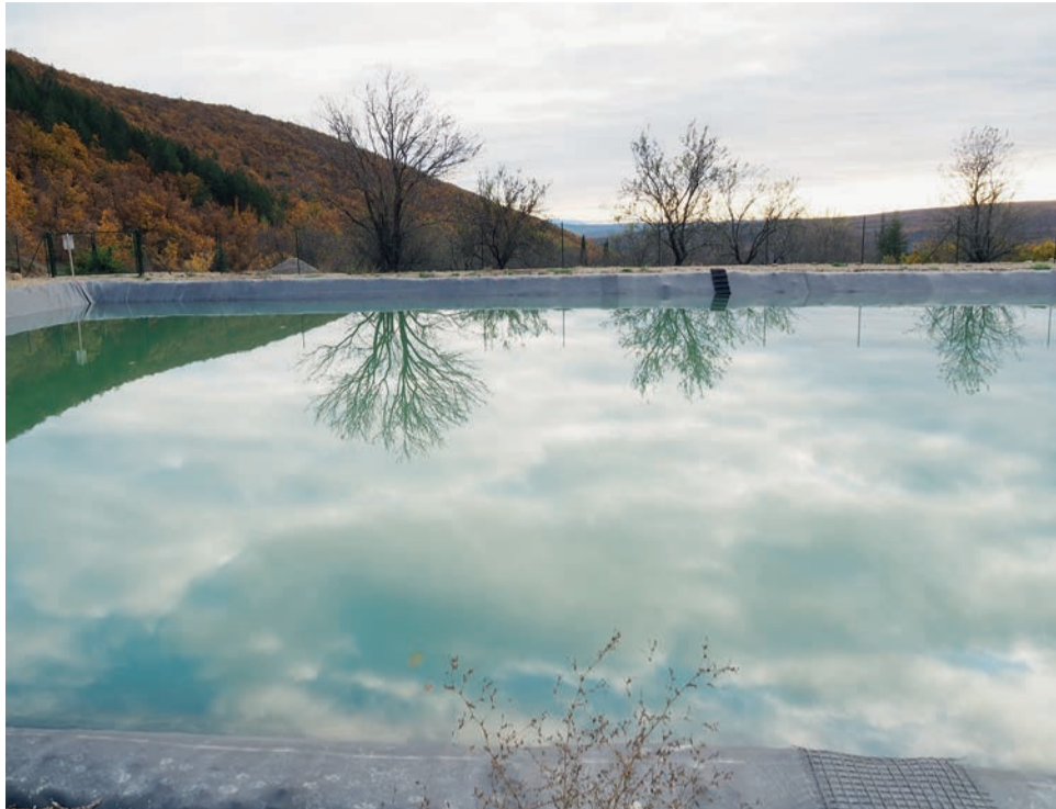
Das Rückhaltebecken bei den Mandelbäumen ist bestens für trockene Zeiten gerüstet.
