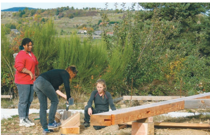
Der Einsatz der Balken in das Fundament ist Präzisionsarbeit.
