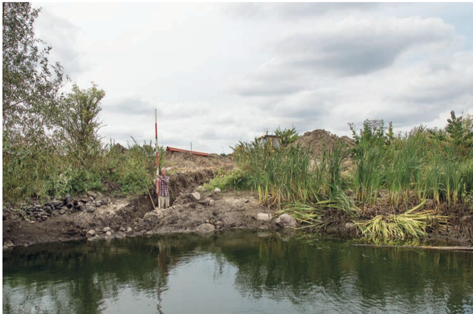
Zu viel Wasser: Die Erneuerung der Drainage soll Abhilfe schaffen.
