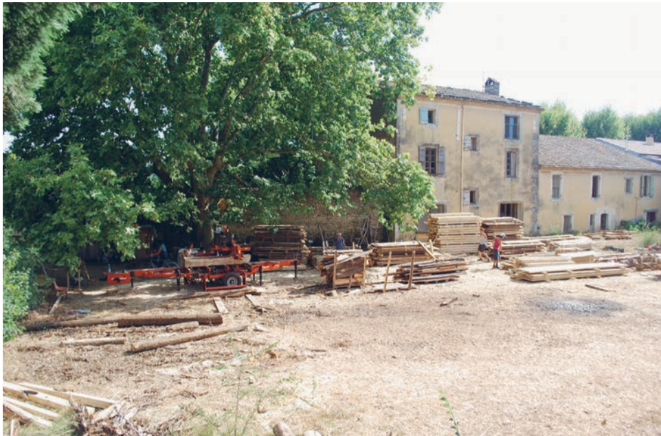
Die Bretter und Bohlen aus den Pappeln warten auf die anstehende Renovierung des Daches.
