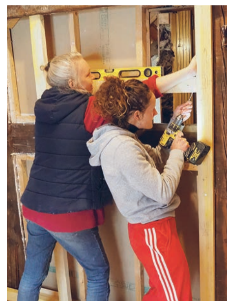
Auch unterm Dach muss gut gedämmt werden.
